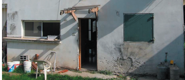
Ściana domu, gdzie uderzyła rakiet.
